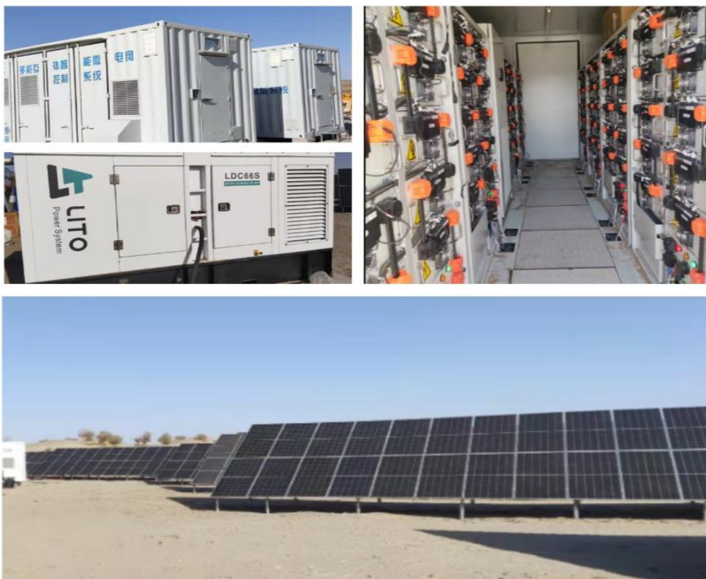
图1 苏州钧灏电力有限公司新疆玛东油田3号井光储柴微电网
